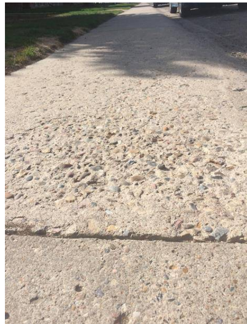
PRV 3 Spalling
