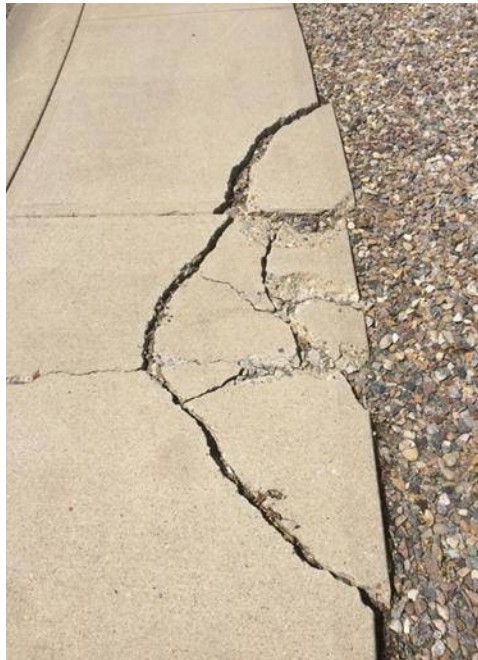
PRV 3 Cracking
