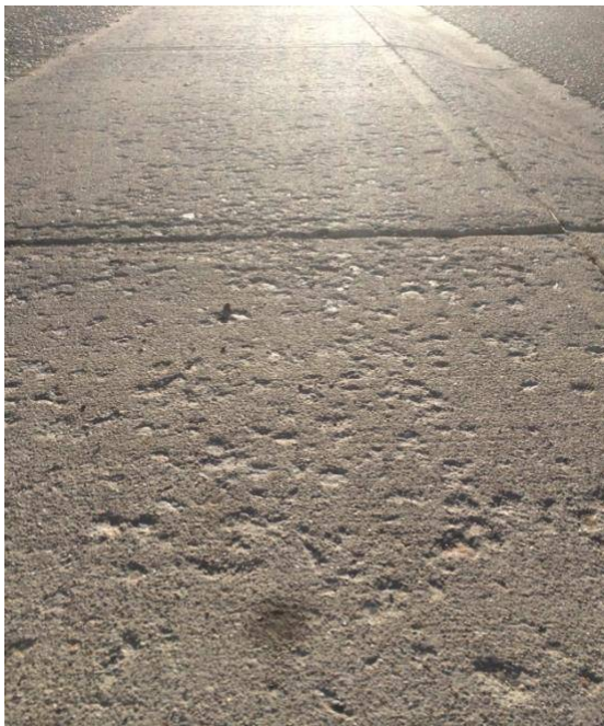
PRV 1 Spalling
